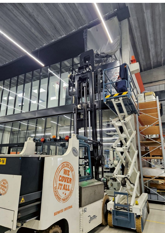
Die Einbringung der neuen Anlage stellte eine Herausforderung dar und musste aufgrund der besonderen Örtlichkeit gut geplant werden.
